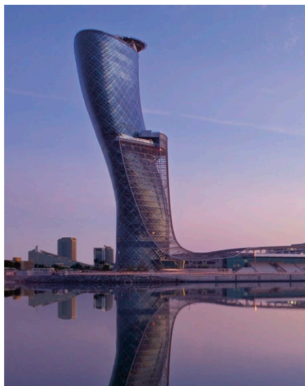
Hyatt Capital Gate, Абу-Даби: верхний душ Raindance S 240 Air 1jet Авторское право: Hyatt Capital Gate
